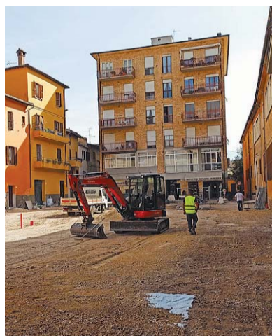
Piazza Giacomini Lavori in corso
