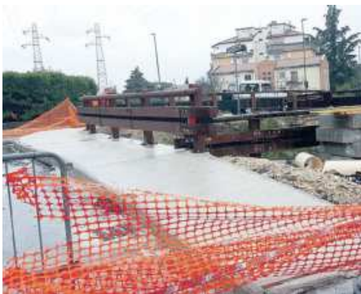
La fase dei lavori in via fiume Albegna
