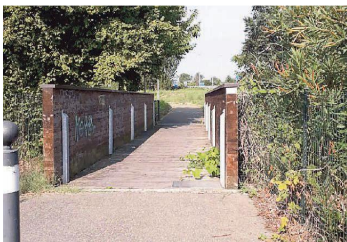
Il ponticello sulla pista ciclabile che porta all'ospedale di Baggiovara
