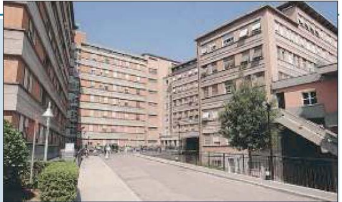
Ospedale di Terni Sono iniziati i lavori per modificare la viabilità
