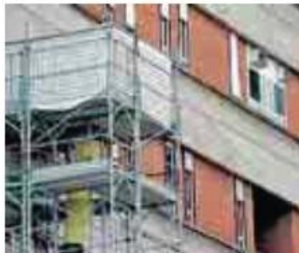
Lavori al Santa Maria di Terni
